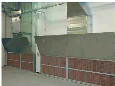
Cabine de pistolage avec pont roulant, éclairage et recyclage de chaleur
